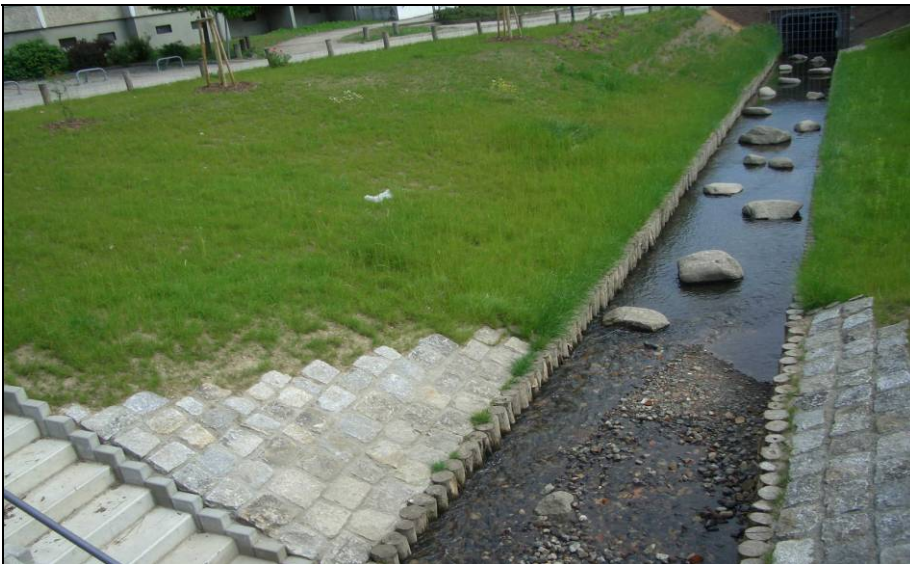
B.6-Maßnahme: Erneuerung des Klingefließes in Frankfurt (Oder)
