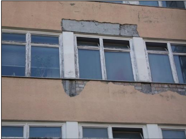
Polizeiinspektion Oranienburg - Fassade
