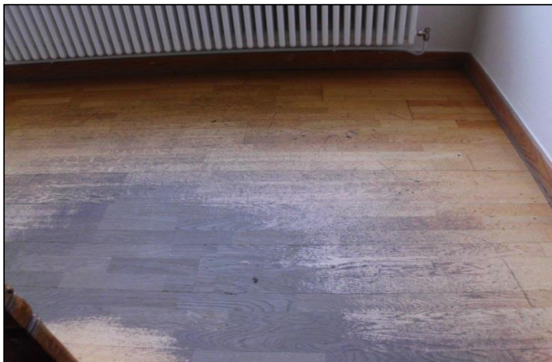
Amtsgericht Zossen - Treppenpodest
