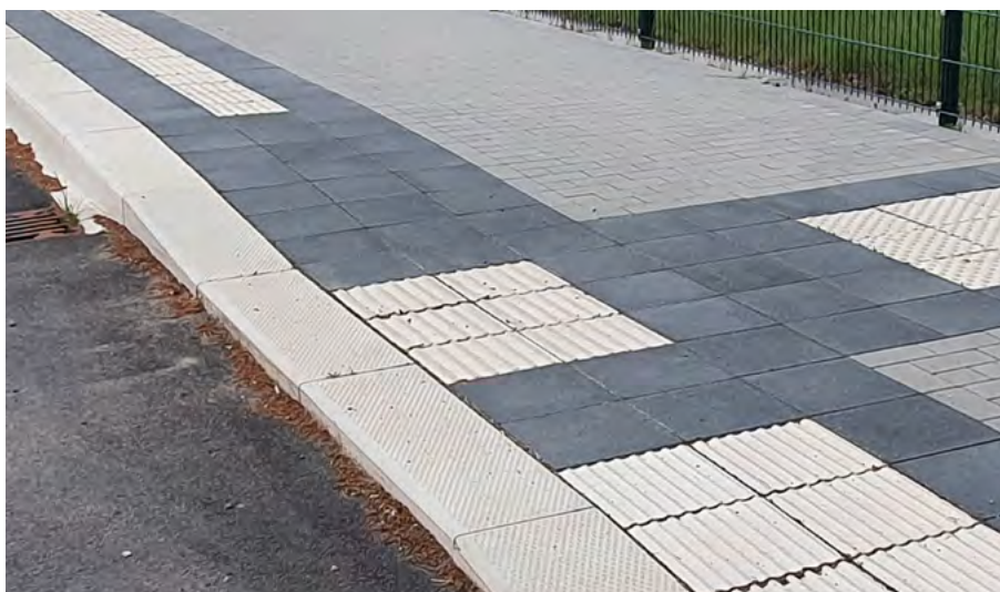
Abbildung 33: Rillen der Richtungsfelder zeigen nicht die Querungsrichtung an Quelle: Landesrechnungshof Brandenburg
