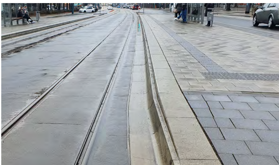
Abbildung 35: Kontrastarme Bodenindikatoren in einem grauen Haltestellenbereich Quelle: Landesrechnungshof Brandenburg
