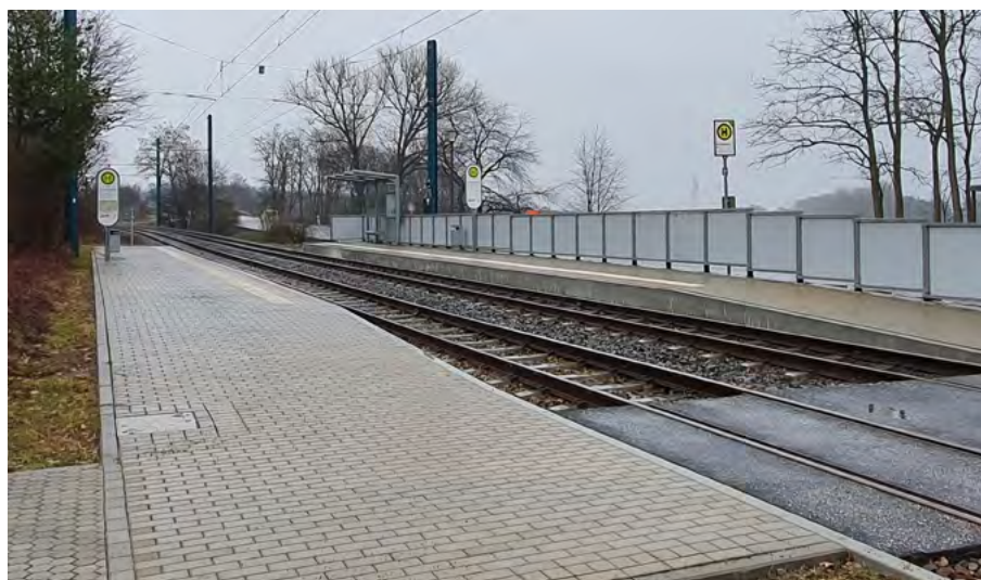
Abbildung 36: Gleisquerung ohne Bodenindikatoren und Auffindungsstreifen Quelle: Landesrechnungshof Brandenburg
